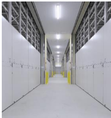
<管理体制の整備された 2ndSTORAGE 倉庫>
